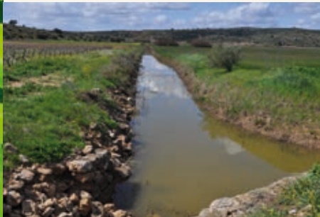
Canaux menant à l'aqueduc sous-terrain
